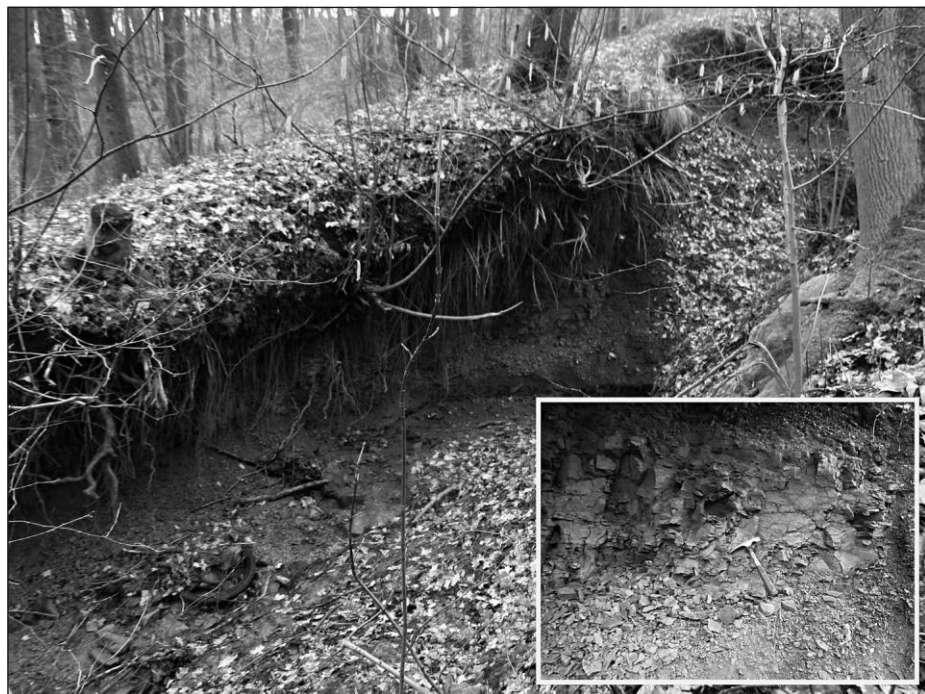
Obr. 1. Erozní zářez pravého břehu Bobřího potoka. Stav v roce 2018.
